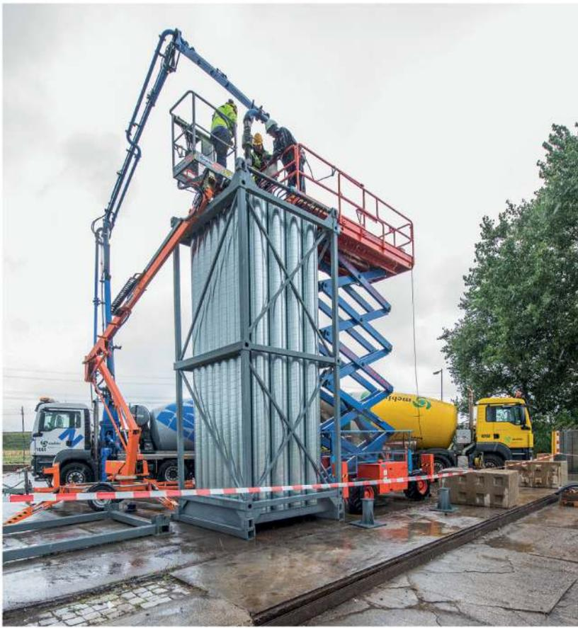
Betonage der Thermischen Batterie mit dem Hochleistungsbeton Heatcrete
